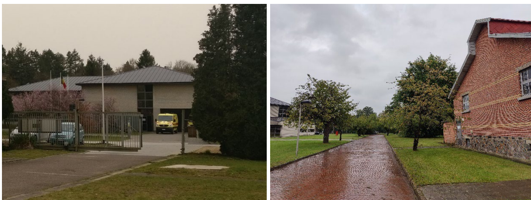
| Medisch centrum Defensie (L) en zicht op binnengebied met medisch centrum aan linkerzijde (R)
